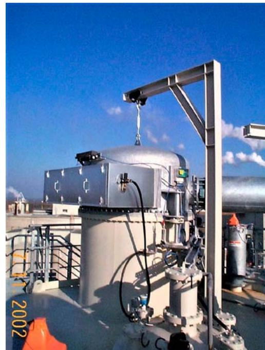
Рис. 2. Силос пылеугольного топлива с отдельно расположенным фильтром
